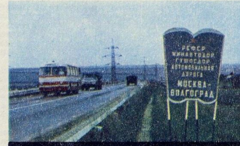
Колесоотбойный брус ограждает дорожное полотно на насыпях и других опасных участках.
